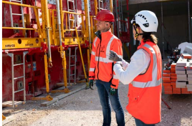
Un conseil terrain sur un poste de travail de coffrage
