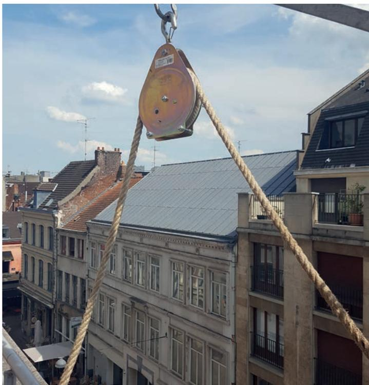
L'intérimaire passait les 4 poignées des big bags dans le crochet de levage, puis soulevait la charge afin que le crochet arrive à l'endroit de la poulie afin de bloquer la charge. Il pouvait ainsi pousser la charge pour l'excentrer et son collègue situé en bas pouvait la faire descendre à l'aide de la corde puis l'évacuer une fois au sol.
